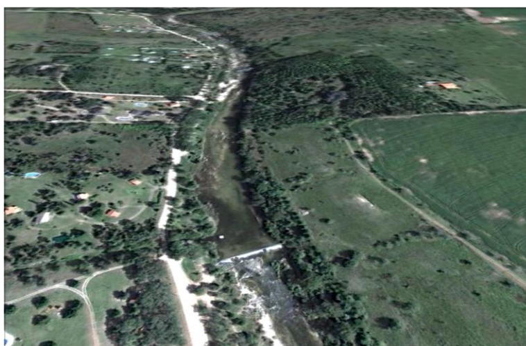
Toma de Agua sobre Río Los Reartes
