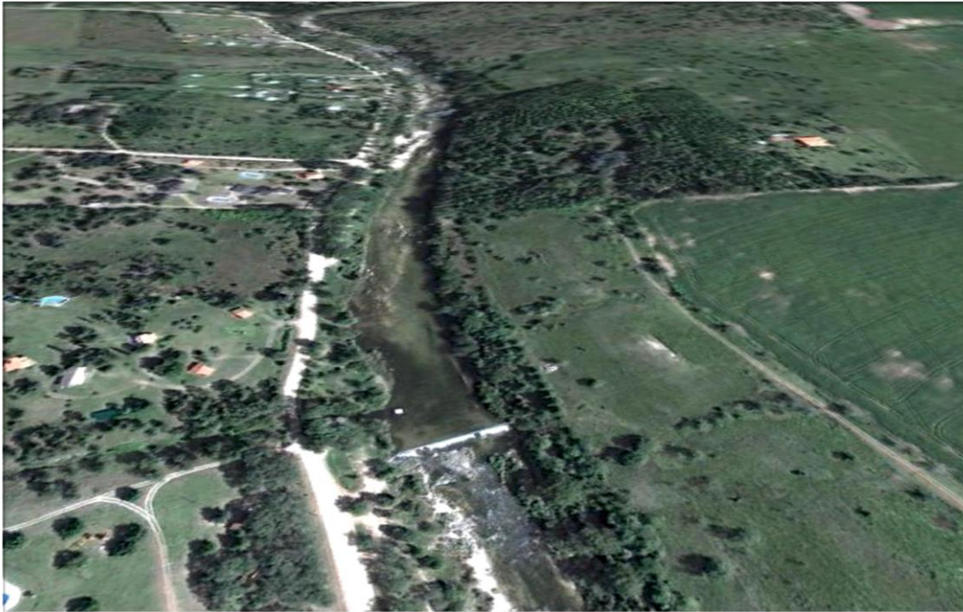
Toma de Agua sobre Río Los Reartes
