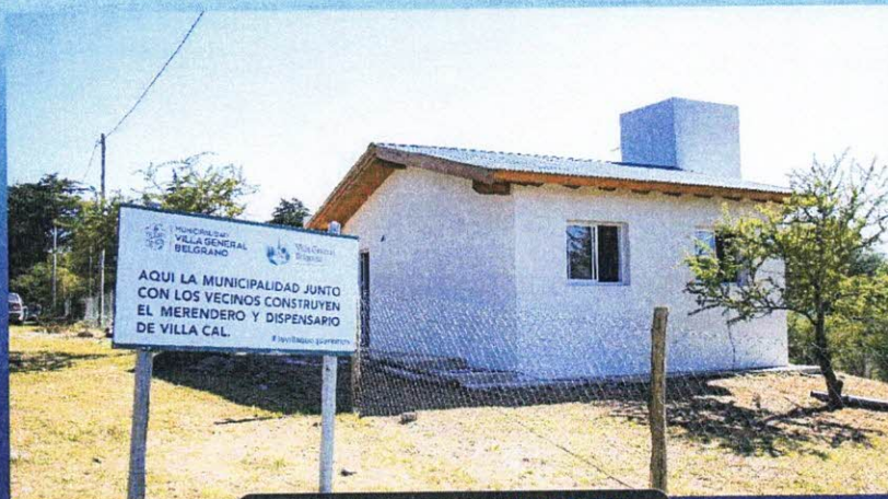
DISPENSARIO Y SUM VILLA CAL
